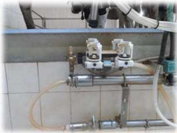
Рисунок 1.19 – Место соединения молокопровода с линией промывки
