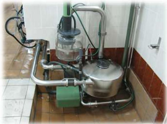
Рисунок 1.18 – Молокоприемный узел с системой защиты от перелива
