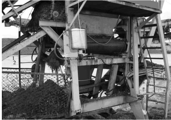
Рисунок 49 – Установка гидроаккумулятора Условные обозначения: 1 – гидроаккумулятор; 2 - блок управления
