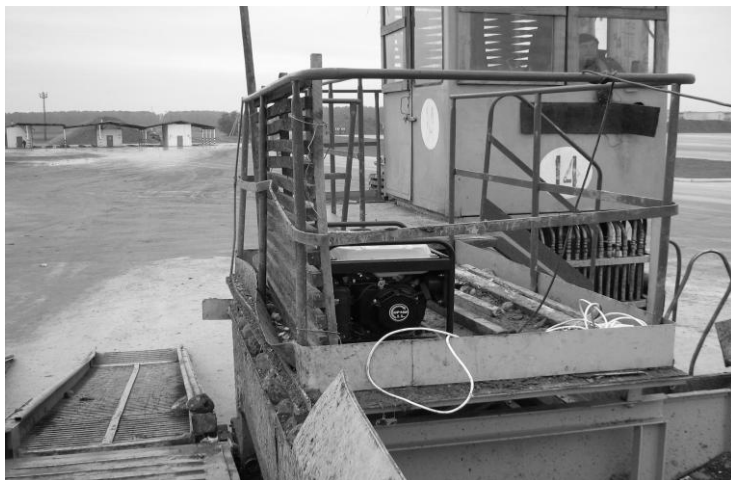
Рисунок 51 – Размещение электростанции на 220 В
